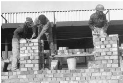
Kőművesek, ácsok, vasbetonkészítők dolgoznak az iskola emeletépítésén és a tanműhelyek építésén
